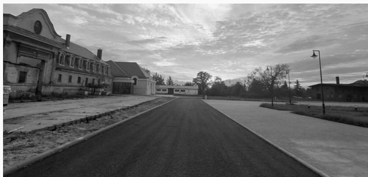
Remont ul. Ogrodowej w Kochcicach w obrębie Gorzelni w Kochcicach
