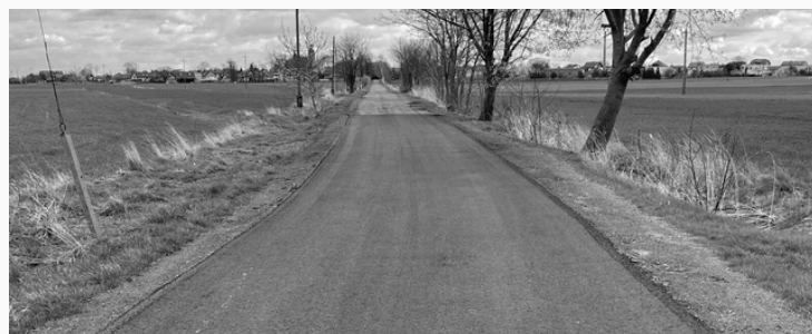
Nowa nawierzchnia ul. Kanus w Lubecku
