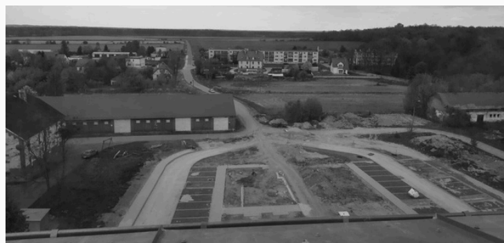
Realizacja zagospodarowania przestrzennego terenu w obrębie zrewitalizowanej Gorzelni w Kochcicach
